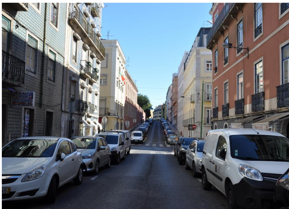
21 – Vista da rua da Belavista para a rua de São Bernardo (poço de ventilação da Estação Estrela) – Distância à zona de intervenção – aprox. 45 m Qualidade visual da área: Média
