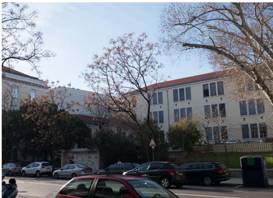
22 – Vista da Av. Álvares Cabral para o Liceu Pedro Nunes (PV1) – Distância à zona de intervenção – aprox. 25 m Qualidade visual da área: Média
