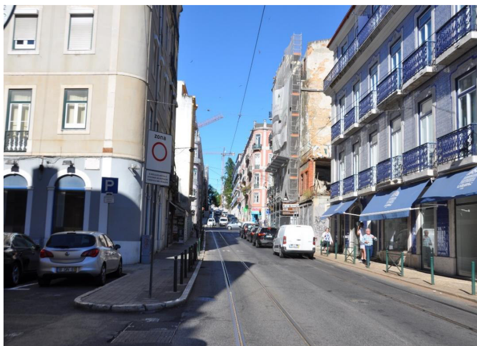
14 – Vista da rua Marquês de Abrantes para W (túnel a céu aberto) – Distância à zona de intervenção – aprox. 30 m
