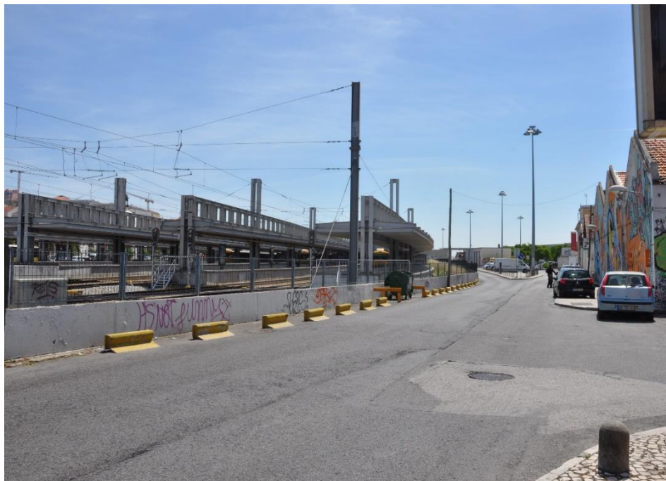
7 – Vista para ENE (Local da Estação Cais do Sodré – acessos à superfície) – Distância à zona de intervenção – aprox. 10 m
