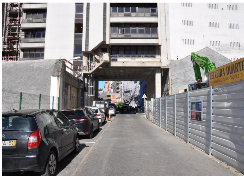
12 – Vista da rua Cais do Tojo para W (t nel a c u aberto) – Dist ncia   zona de interven o – aprox. 40 m Qualidade visual da  rea: M dia a reduzida
