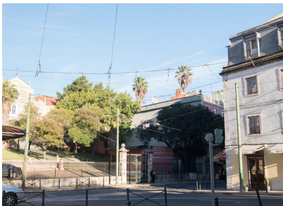
20 – Vista da esquina da rua João de Deus para a entrada do Hospital Militar (Estação Estrela) – Distância à zona de intervenção – aprox. 40 m Qualidade visual da área: Média a Elevada
